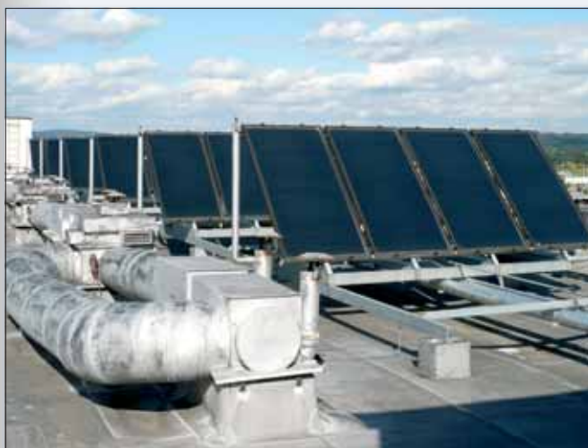
Umístění solárních kolektorů na střeše. Zdroj: DS Hvizdal, České Budějovice
