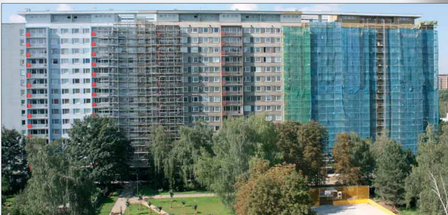
Průběh zateplování fasády panelového objektu. Zdroj: Lafarge Cement Journal
