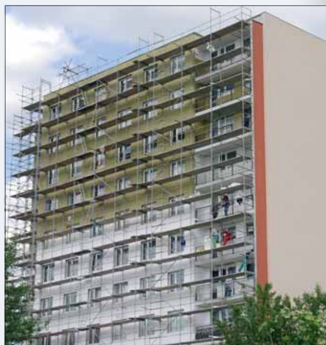
Použití různých tepelně izolačních materiálů při zateplování panelového domu. Zdroj: EkoWATT
