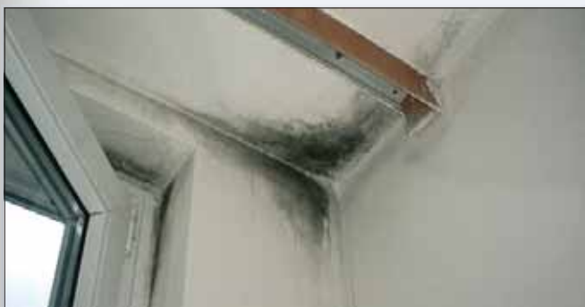
Důsledky špatného řešení tepelných mostů. Zdroj: EkoWATT
