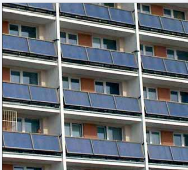
Umístění solárních kolektorů na lodžích. Zdroj: EkoWATT
