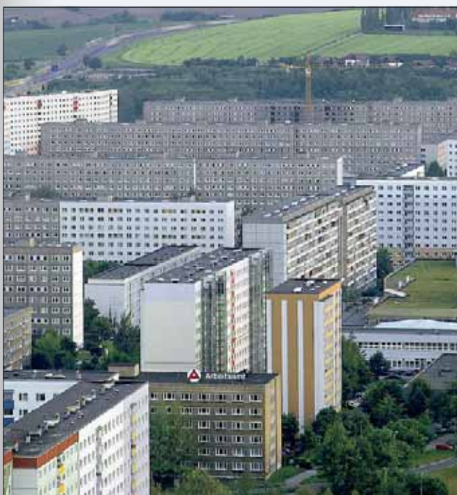
Panelové sídliště. Zdroj: EkoWATT
