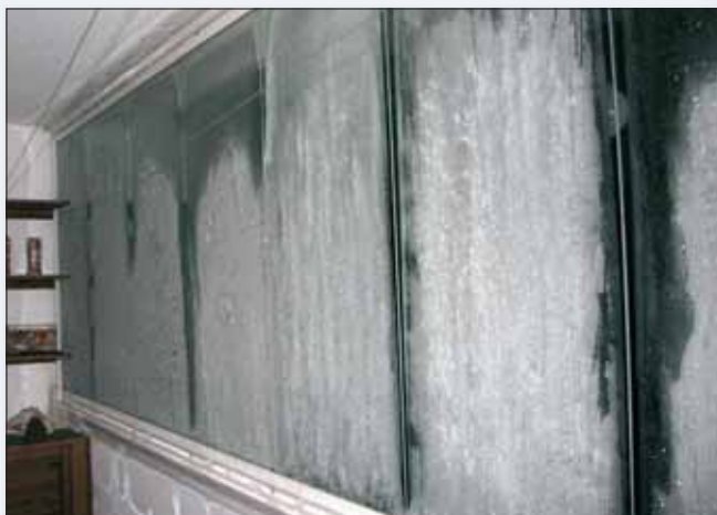
Příklad nedostatečného větrání lodžie. Zdroj: EkoWATT
