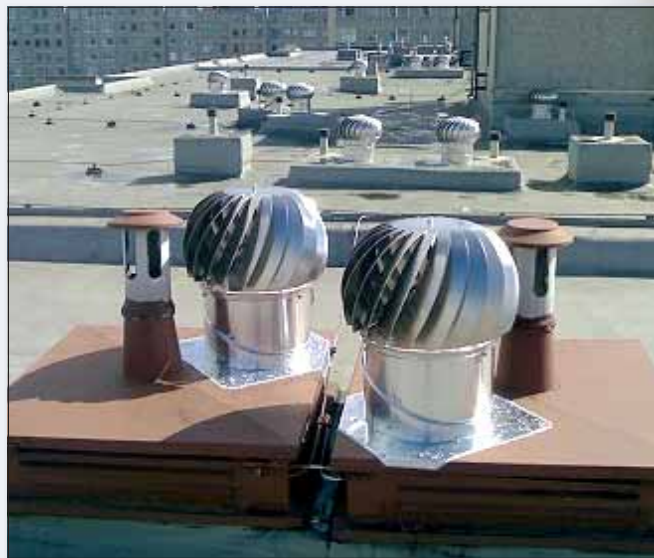
Rotační hlavice umístěné na střeše panelového domu. Zdroj: EkoWATT
