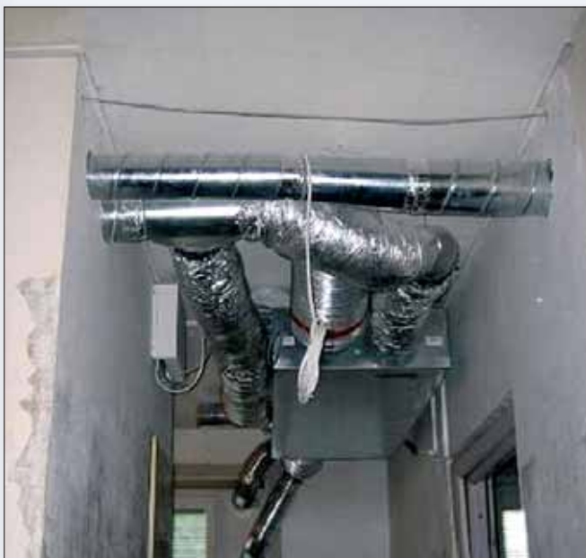
Umístění lokální rekuperační jednotky na chodbě. Zdroj: Atrea
