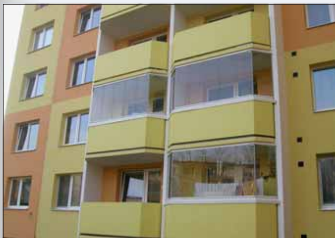
Zasklení nezateplené lodžie. Zdroj: Optimi®
