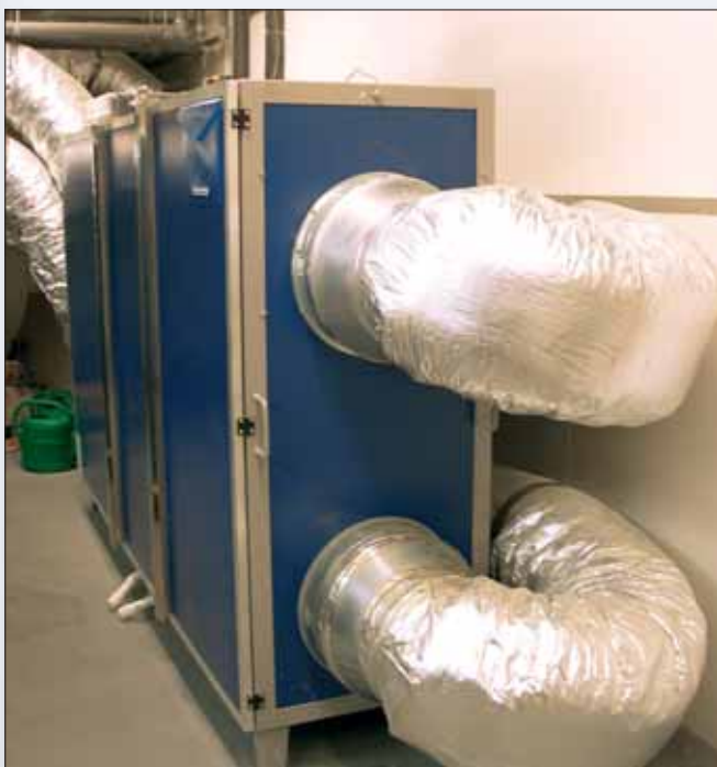
Centrální rekuperační jednotka. Zdroj: EkoWATT
