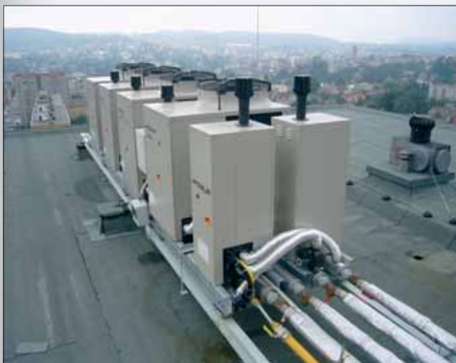
Plynová tepelná čerpadla. Zdroj: Robur
