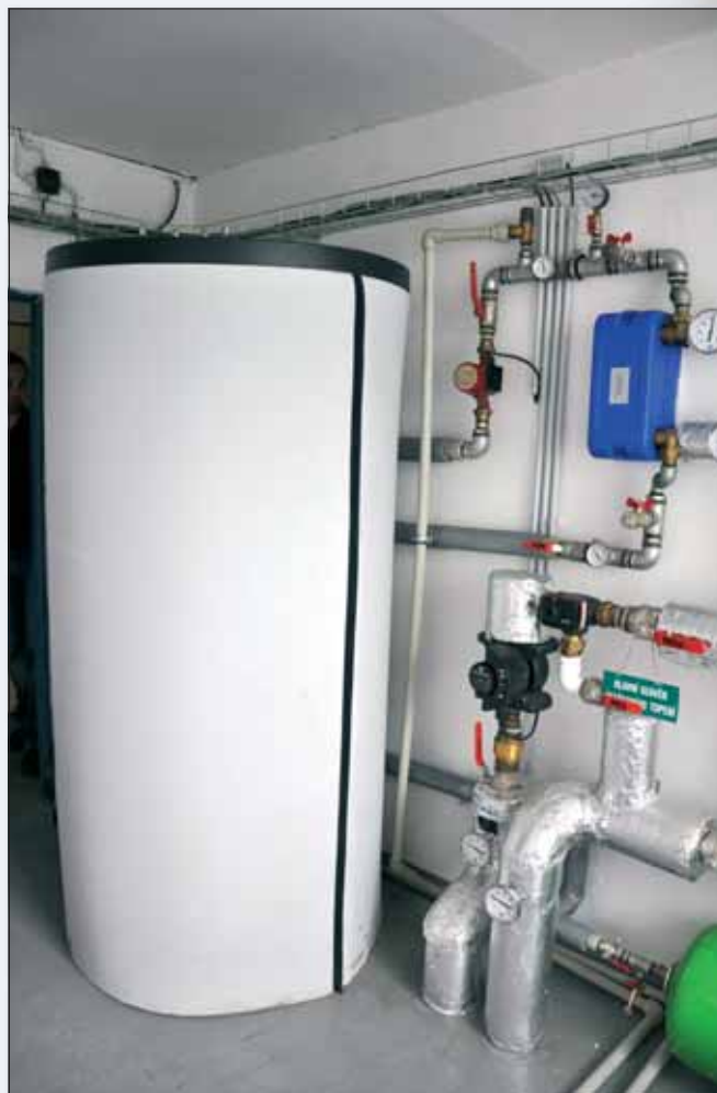
Centrální akumulční zásobník. Foto: EkoWATT
