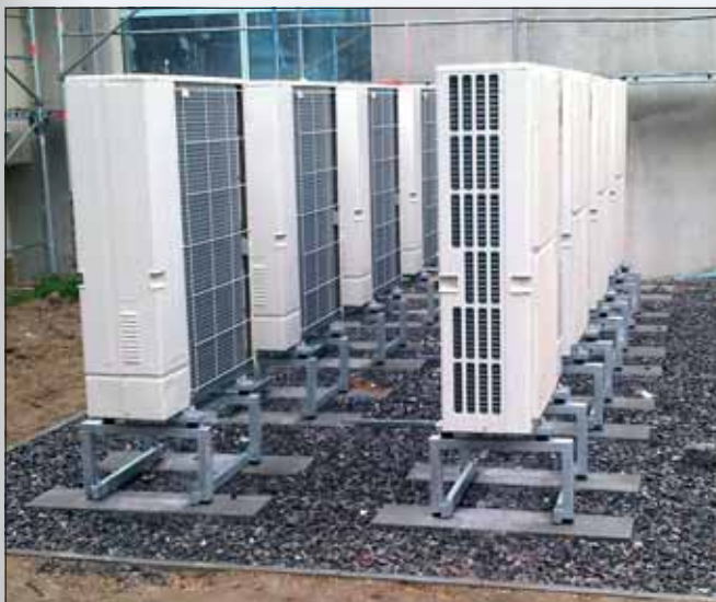
Kaskáda elektrických tepelných čerpadel vzduch – voda. Zdroj: Tepelná čerpadla IVT
