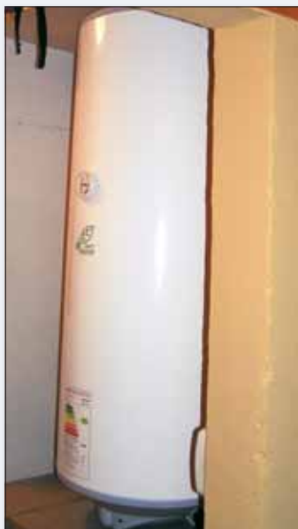
Umístění elektrického akumulčního ohříváče na chodbě bytu v panelovém domě. Zdroj: Matuška
