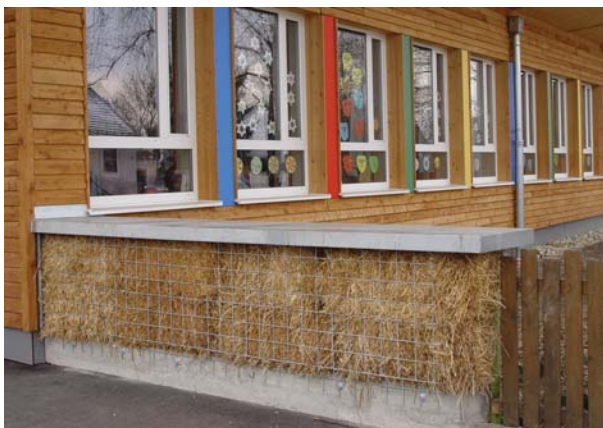
Pro zateplení lze použít i slámu (základní škola Absdorf, Rakousko)
