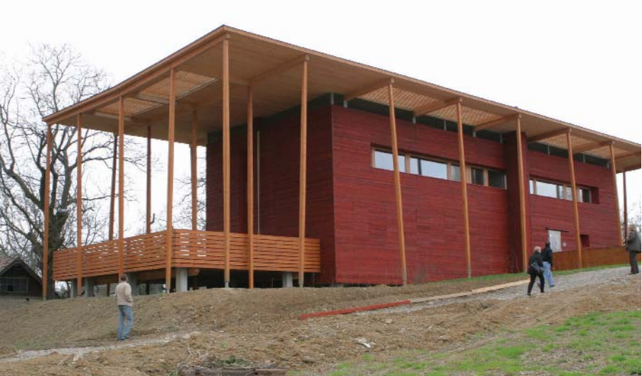
Kancelářská budova v pasivním standardu (Böheimkirchen, Rakousko)
