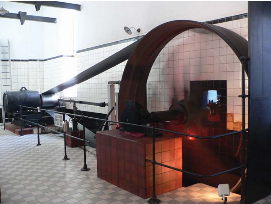
Malá vodní elektrárna v Písku byla od svého vzniku důležitým zdrojem elektřiny pro město, dnes je turistickou atrakcí
