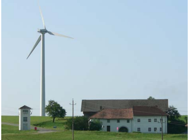
Větrná elektrárna může stát i poměrně blízko obytných domů (Windhaag, Rakousko)
