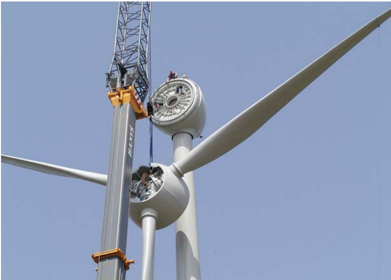
Montáž obecní větrné elektrárny (Jindřichovice pod Smrkem)
