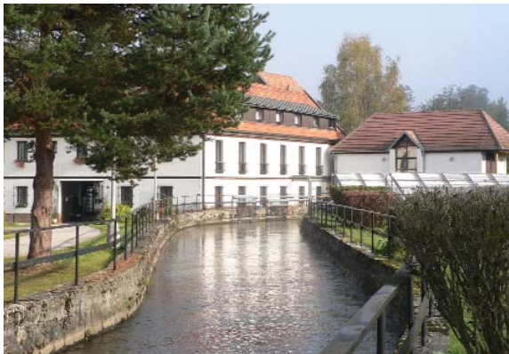
Tepelné čerpadlo v rekreačním objektu ČVUT ochlazuje vodu v náhonu malé vodní elektrárny (Herbertovy)
