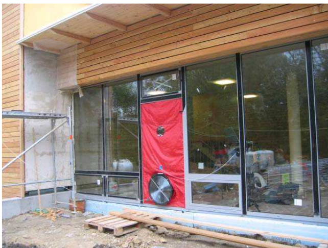
Obrázek 18: Test těsnosti budovy (Blower-door test) je nezbytný pro kontrolu kvality stavby.
