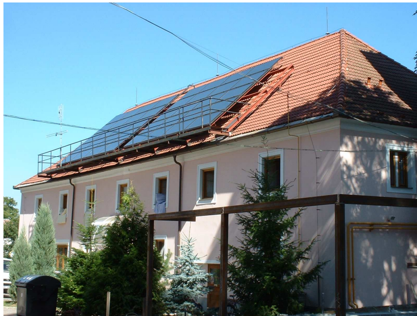
Obrázek 4: Solární systém pro ohřev vody v ústavu sociální péče.
