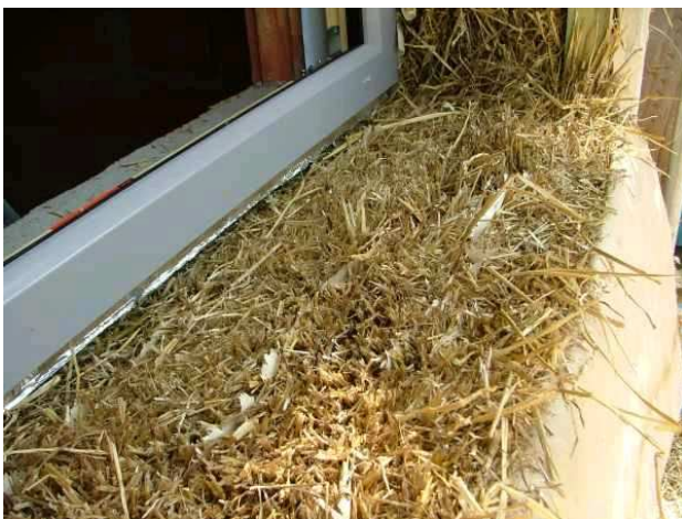
Obrázek 16: Některé stěny jsou izolovány slámou.
