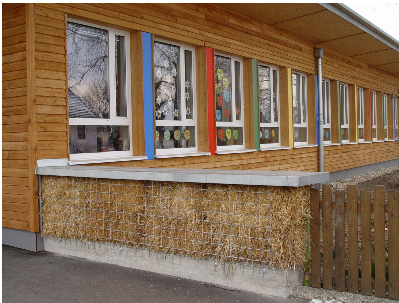
Obrázek 11: Základní škola v rakouském Absdorfu, při rekonstrukci byly pro zateplení použity balíky slámy.
