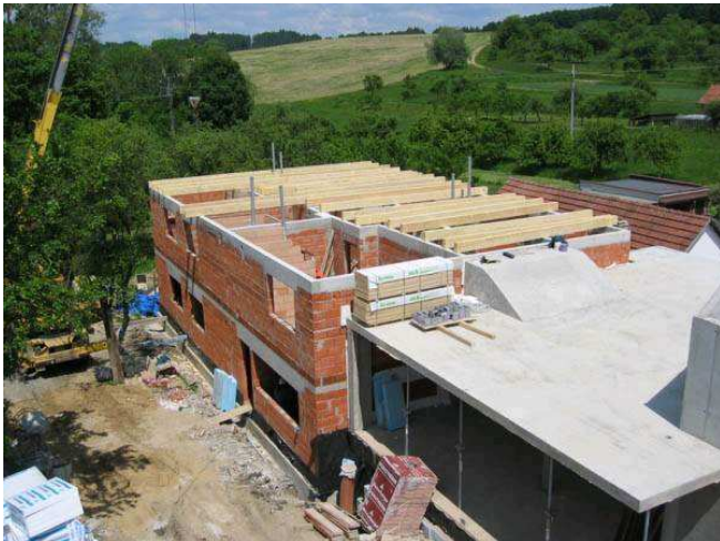
Obrázek 17: Nosná konstrukce ubytovny je zděná, budova seminárního centra je železobetonový skelet.
