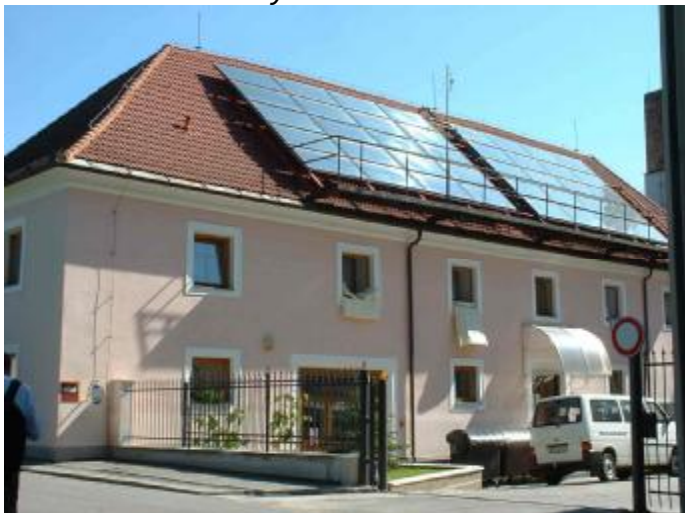
Obrázek 6: Solární systém na historické budově v Libníči.
