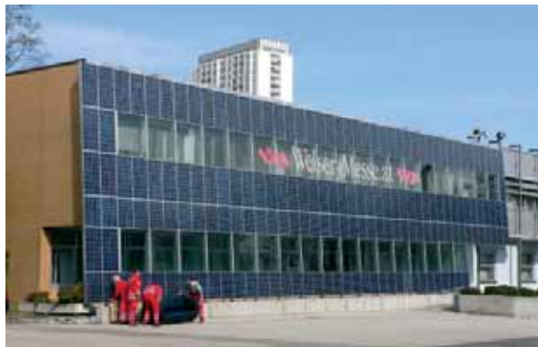
Fasáda z fotovoltaických panelů. Foto: Karel Srdečný
