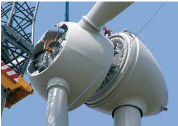
Montáž větrné elektrárny (ČR). Foto: Jiří Beranovský, EkoWATT
