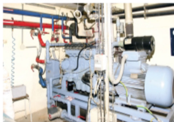
Základem mnoha kogeneračních jednotek je upravený motor z automobilu, na snímku bez ochranného krytu. Foto: EkoWATT
