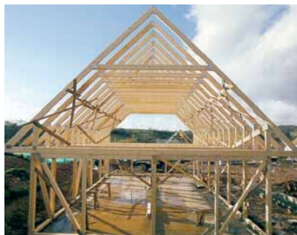
Dřevostavba je jednou z možností jak postavit pasivní dům. Foto: J. Antonín, EkoWATT
