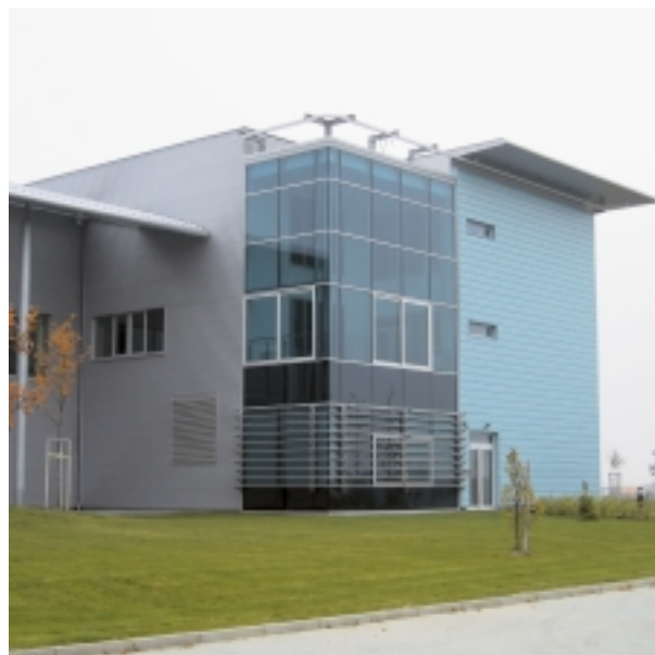
Administrativní budova – Řízení letového provozu, Ruzyně. Foto: EkoWATT.
