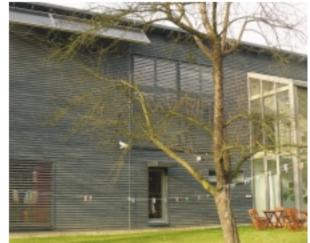
Centrum ekologické výchovy Střelkovičky, Oldřichov v Hájích. Nízkoenergetický dům. Foto: Ekowatt.
