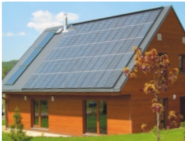
Pasivní dům, Koberovy. Foto: EkoWATT.
