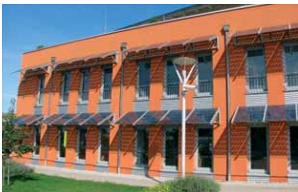
Fotovoltaické panely jako stínící prvek. Foto: Petr Kotek, EkoWATT
