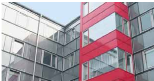
Odstranění tepelných mostů u balkonů jejich zasklením. Foto: Z. Ročárek
