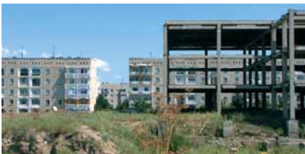
Panelové domy v Kyrgyzstánu. Foto: Petr Kotek, EkoWATT
