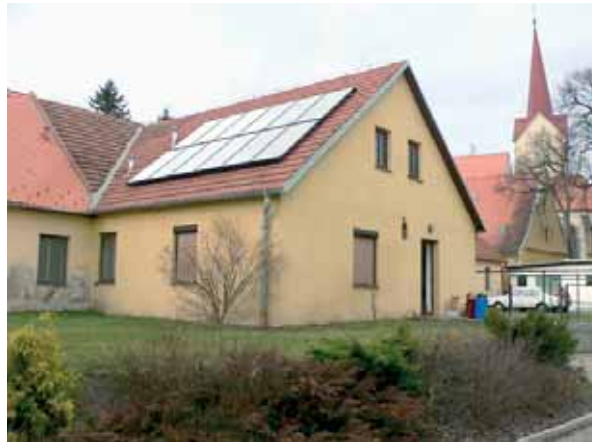
Solární systém na historickém objektu poblíž památkové zóny v Telči. Foto: Karel Srdečný
