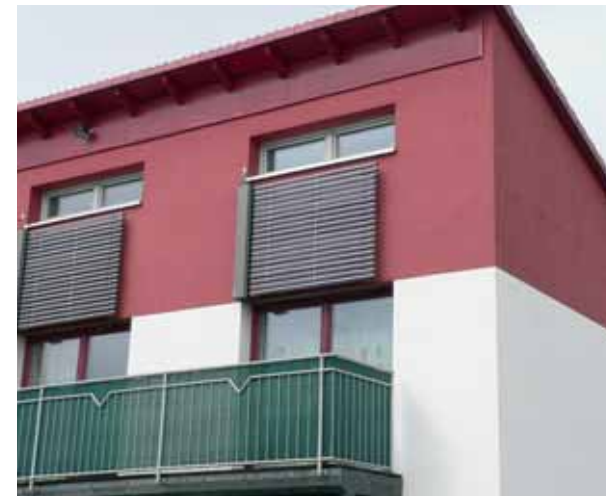
Vakuové kolektory lze efektivně využít i na svislé fasádě. Foto: Lenka Bradnová, EkoWATT.
