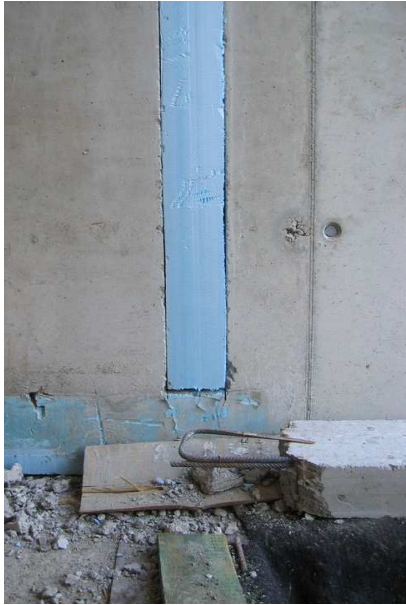
Detail: termické oddělení vytápěné a nevytápěné části u vchodu do kuchyně
